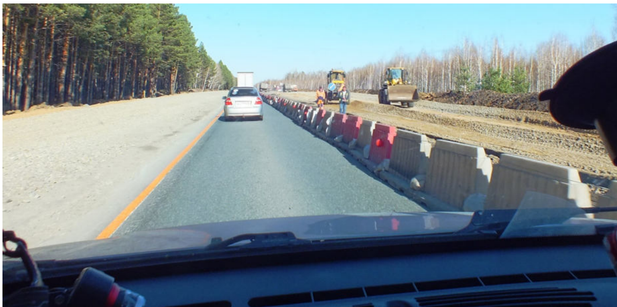
Фото 02.21. Снова – капитальный ремонт дороги
