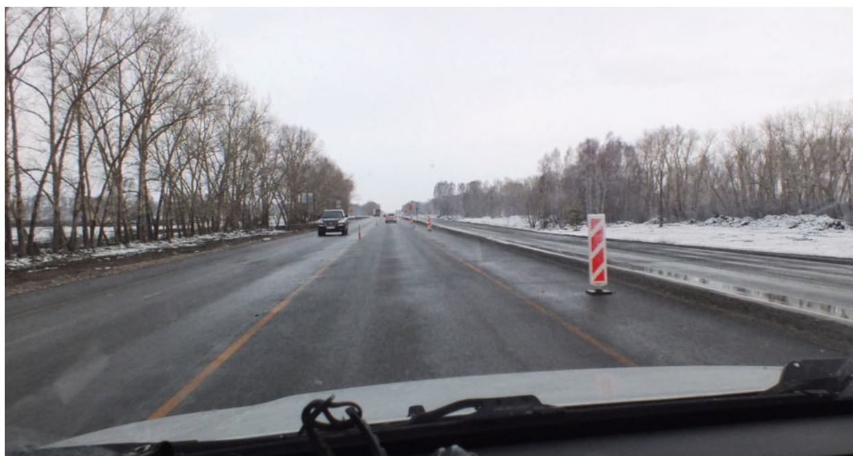
Фото 04.48. Снег лежит по обеим сторонам, здесь еще холоднее, -1»С
