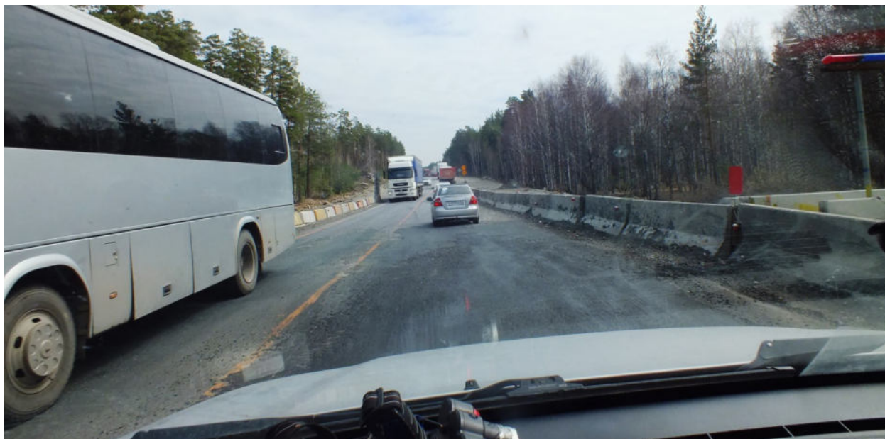
Фото 02.15. Ремонт на М5 летом почти всегда...
