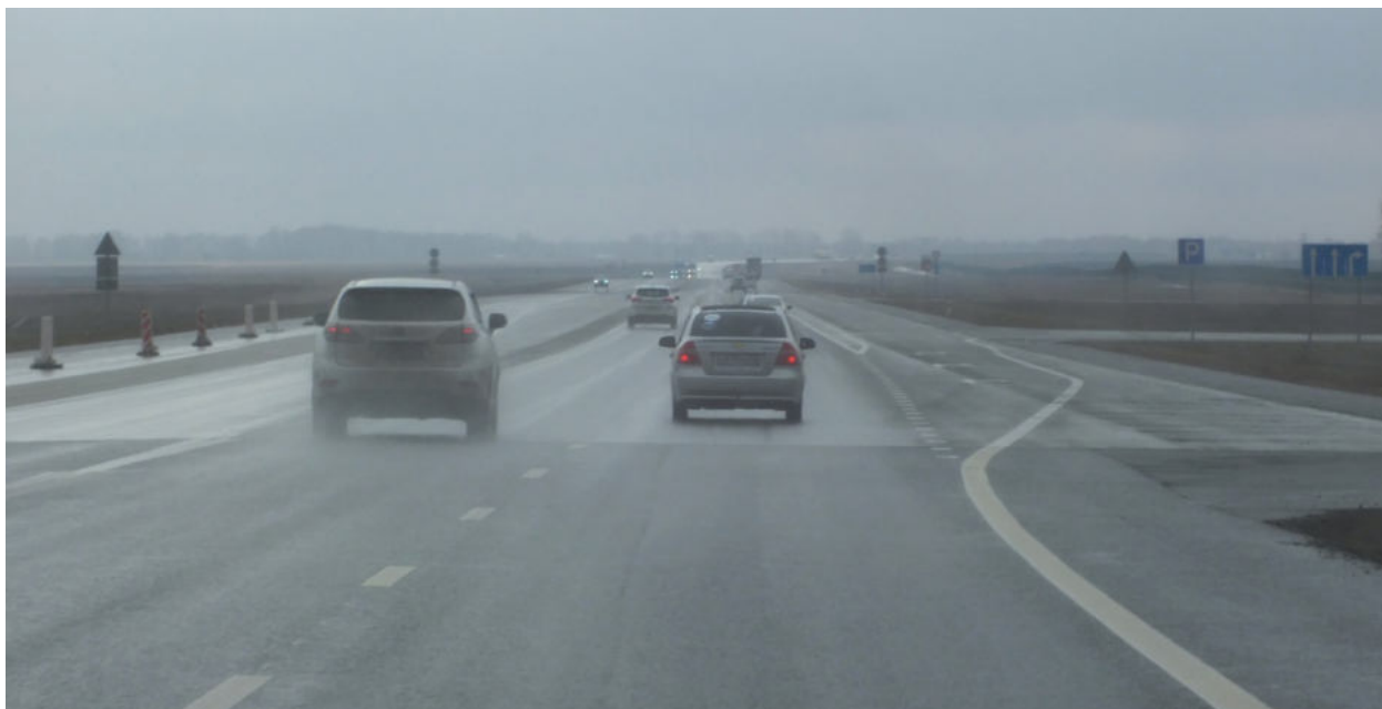
Фото 05.07. Проходим участок широкой «бетонки»
