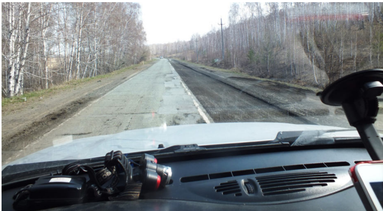
Фото 02.06. Проходим участок ремонта дороги на г.Учалы
